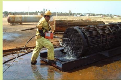
Figure n°2 : utilisation de la lance en mode manuel par l'opérateur
